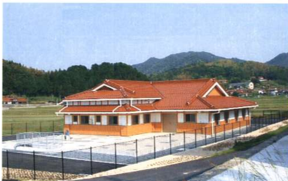
農業集落排水事業 福川地区（萩市）処理施設
