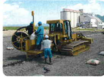
ベストドレーン施工
