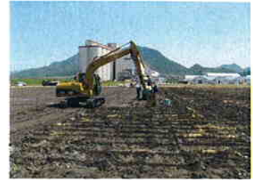
補助孔（I+Ⅲ型）施工
