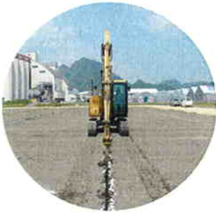
フォアスカッター施工
