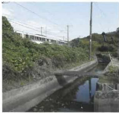
御撫育用水。山陽本線を走る列車と用水路の風景も印象的。幹線用水路は最も深い取水口のところで深さ3メートル。最も幅が広いところで3.4メートル
