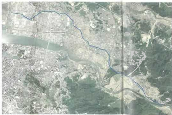
御撫育用水ルート。左方向が河口側。山口県土地改良事業団体連合会作成
