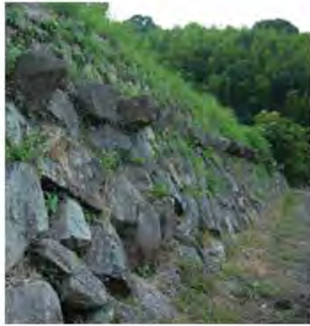
石積み技術は巧妙で、法面を歩くための足場が見事に組み込まれている
